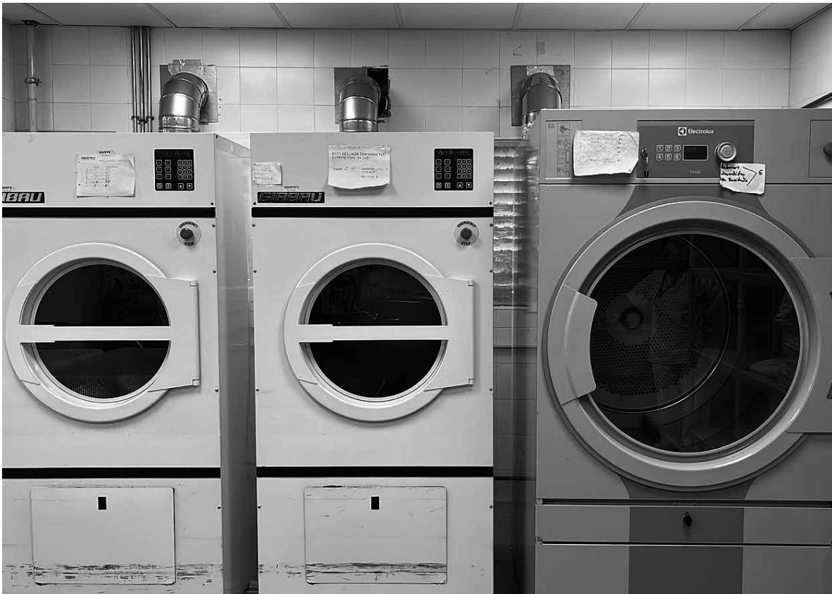
Imagen de la lavandería del centro.
