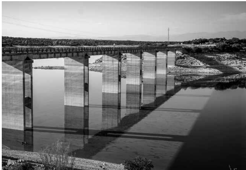
Puente sobre el embalse de Valdecañas.
