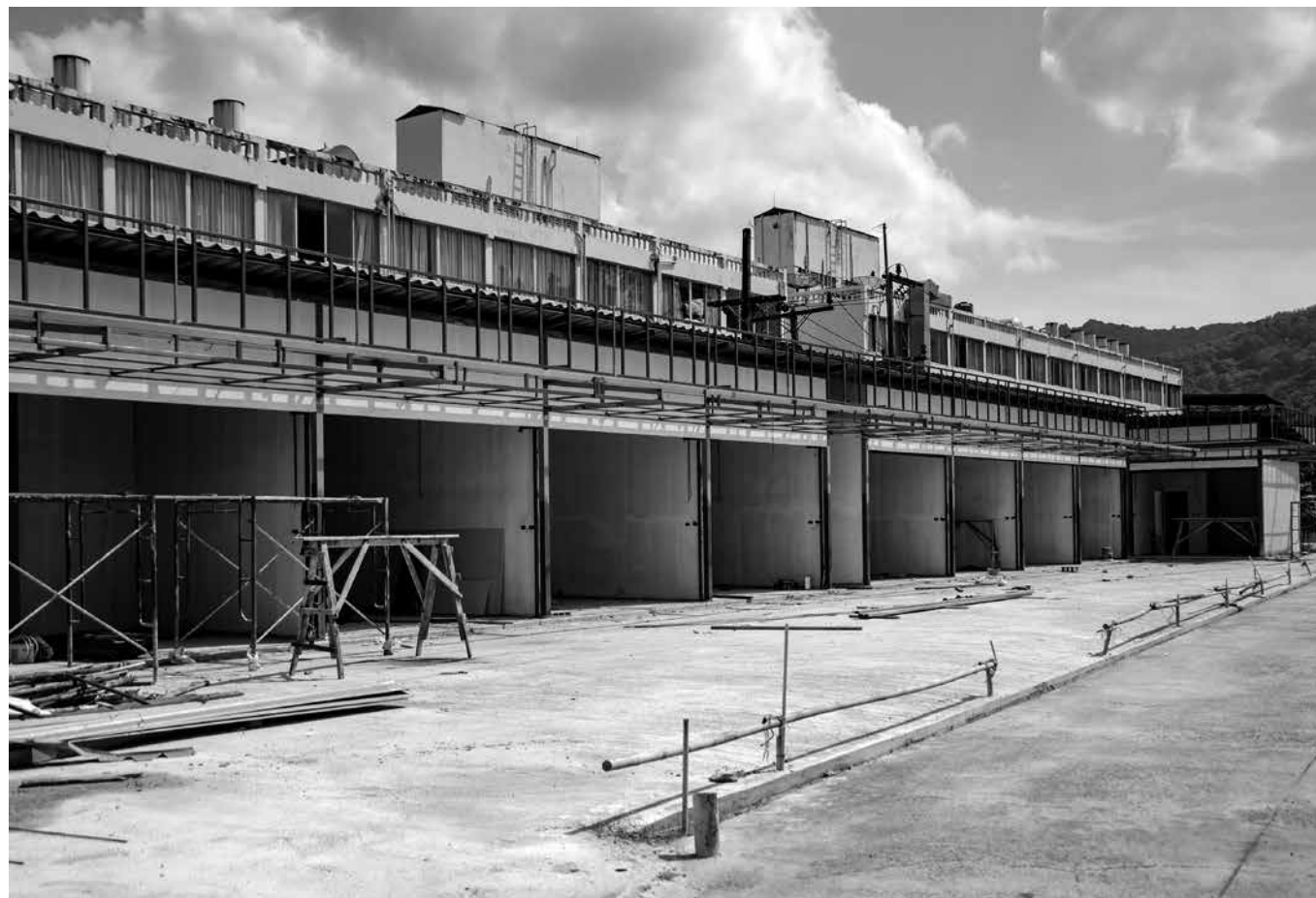
Imagen de la construcción de un hotel industrializado.
