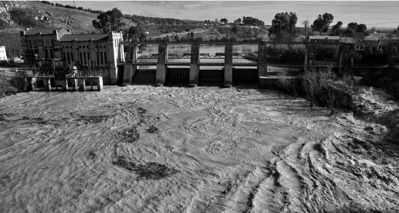
La hidroeléctrica de Mengibar.
